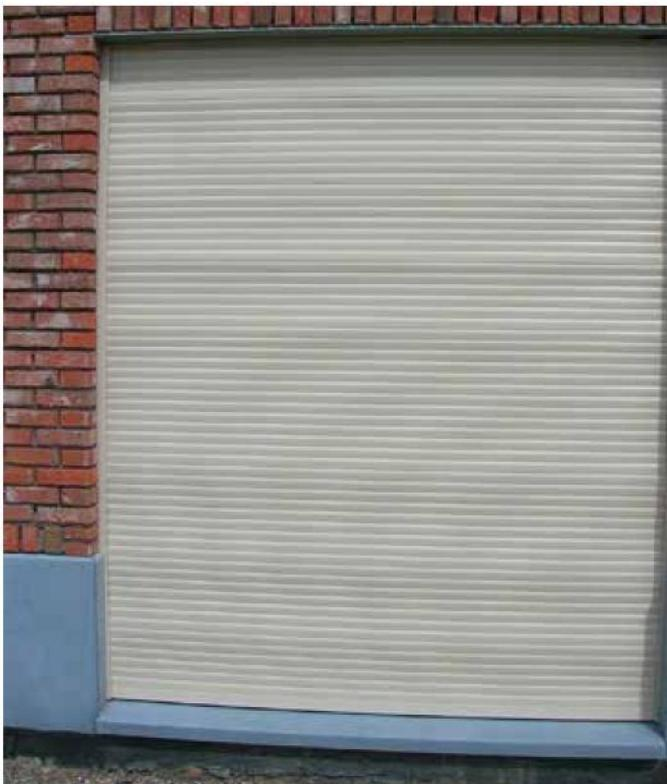
*Bild 4: Welligkeit von Rollladenpanzern*
